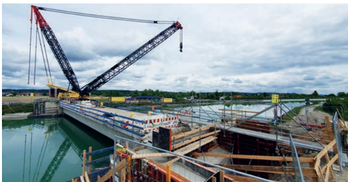
Abbau der alten Brücke, Foto: Rupert Joachimbauer
